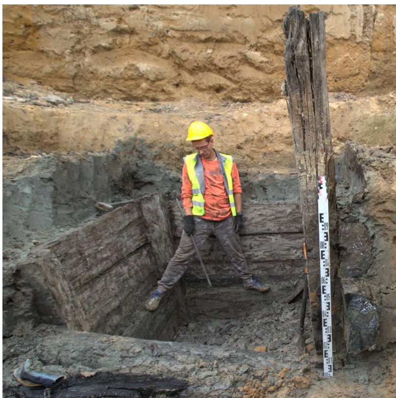
Ryc. 7. Przekrój ściany studni. Silny napływ wód gruntowych zniszczył konstrukcję po jej wyeksplorowaniu. Fot. A. Ginter
