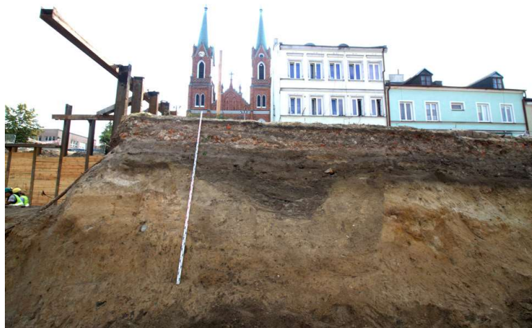
Ryc. 13. Profil wkopu budowlanego i rozbiórkowego studni nr 5 od strony wschodniej. Fot. A. Ginter
