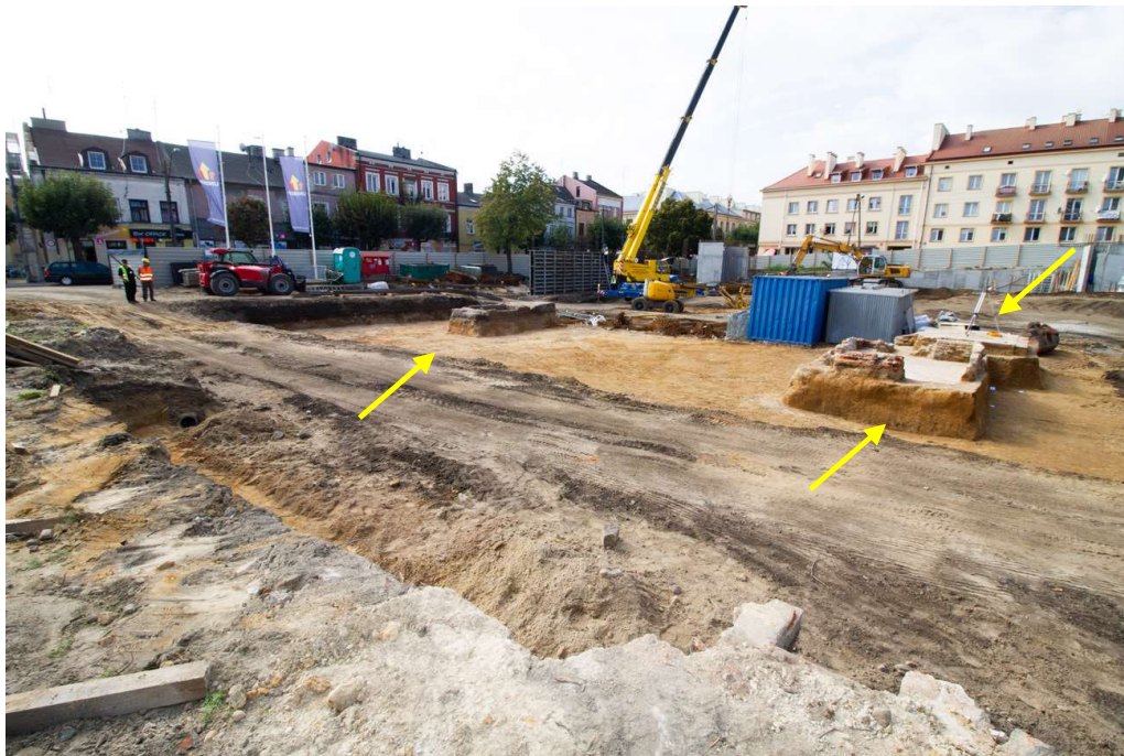
Ryc. 33. Widok w kierunku południowo-zachodnim na odkryte pozostałości zabudowy murowanej. Po prawej stronie konstrukcje związane z zabudową ratuszową, po lewej stronie, w głębi zdjęcia niewielki budynek gospodarczy. Fot. A. Ginter
