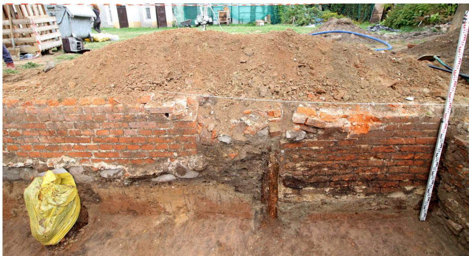
Ryc. 20. XIX wieczne konstrukcje odkryte w wykopie 3/2018. Widok w kierunku południowym. Fot. A. Ginter
