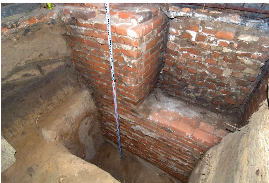
Ryc. 11. Fundament ryzalitu południowego korpusu głównego pałacu. Widok w kierunku południowo-wschodnim. Fot. A. Ginter
