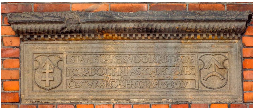
Ryc. 2. Zdjęcie płyty wmurowanej w elewację obecnego kościoła
