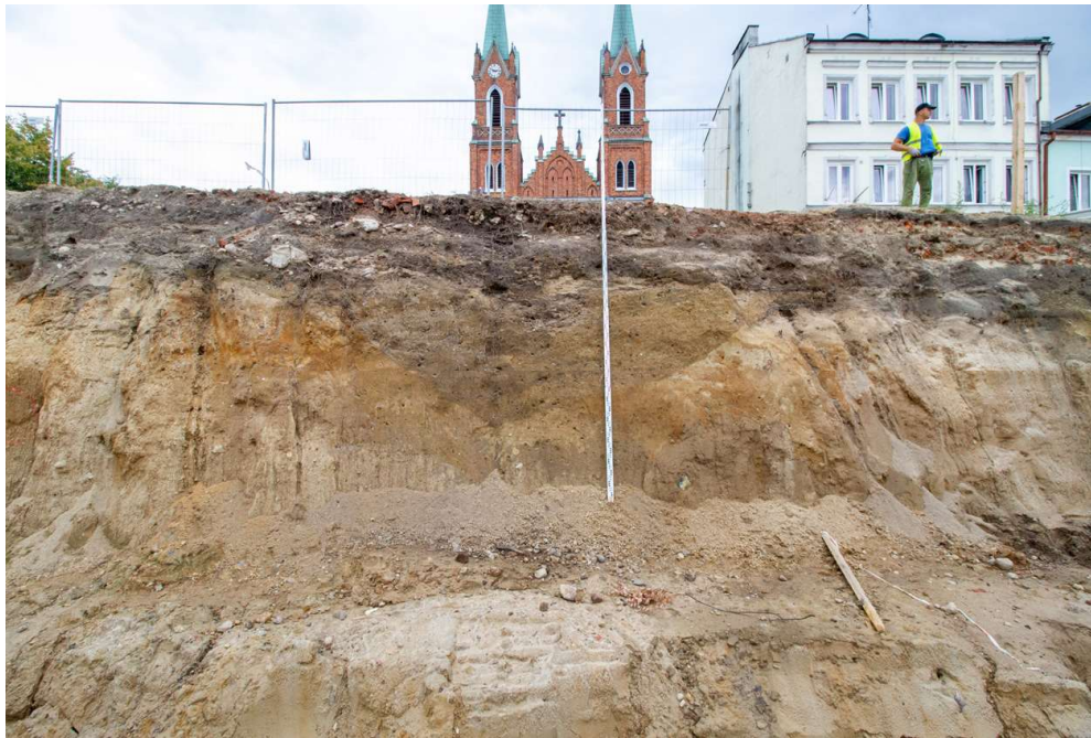
Ryc. 10 - Wkop budowlany studni nr 4 – profil. Fot. A. Ginter
