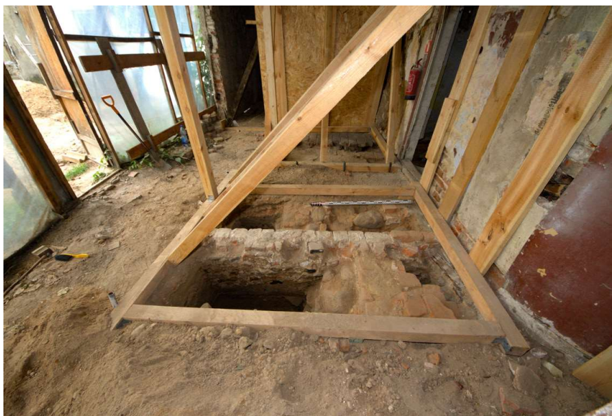
Ryc. 6. Wykop 38. Na zdjęciu relikty fundamentu klatki schodowej, kominka oraz wymurowanej na nich ścianki działowej. W obrębie niewidocznego północnego profilu znajduje się fundament pierwotnej ściany magistralnej zamykającej od północy zachodnie skrzydło pałacowe. Widok w kierunku południowym. Fot. A. Ginter
