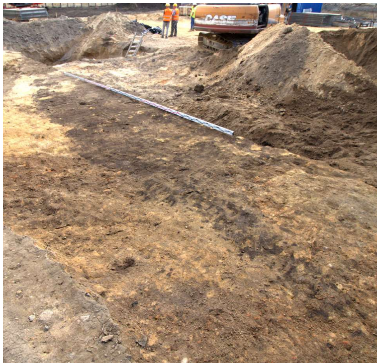
Ryc. 25. Widoczny zarys zbiornika i kanału doprowadzającego wodę. Fot. A. Ginter
